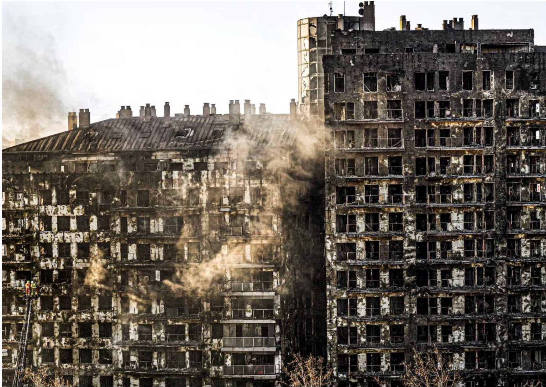
11. Estado del edificio del barrio de Campanar de Valencia donde fallecieron 10 personas, el 23 de febrero.
